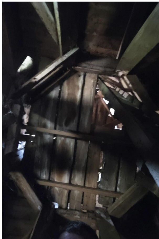
Zdjęcie nr 13, 14 – Konstrukcja drewniana sygnaturki
