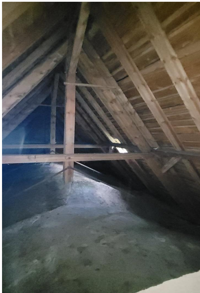
Zdjęcie nr 17 - Konstrukcja dachu wraz ze sklepieniem.
