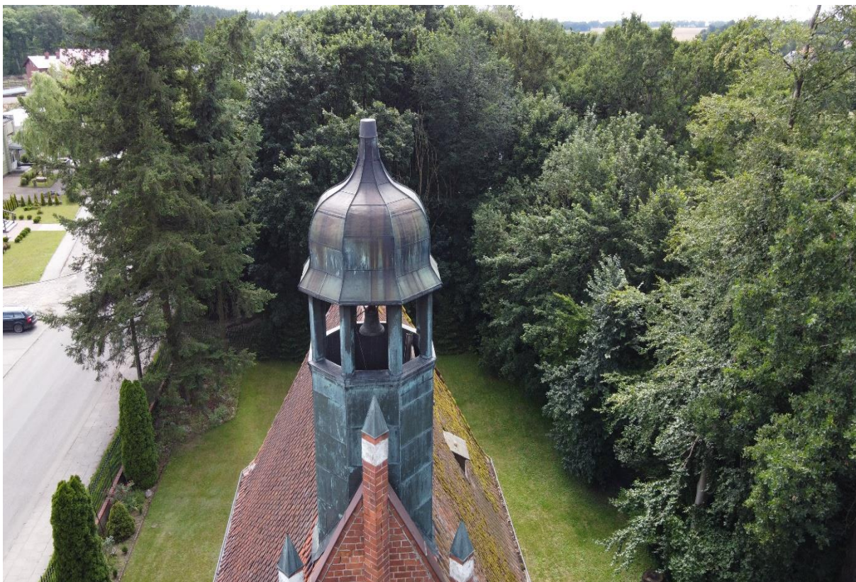
Zdjęcie nr 12 – Sygnaturka – widok ogólny, brak iglicy
