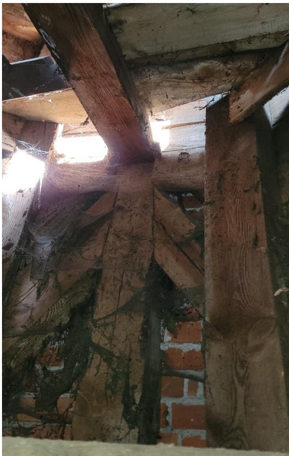
Zdjęcie nr 13, 14 – Konstrukcja drewniana sygnaturki
