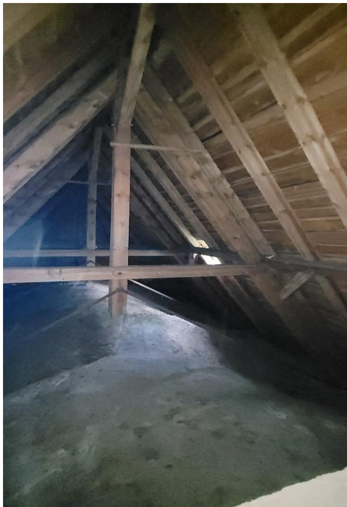
Zdjęcie nr 17 - Konstrukcja dachu wraz ze sklepieniem.
