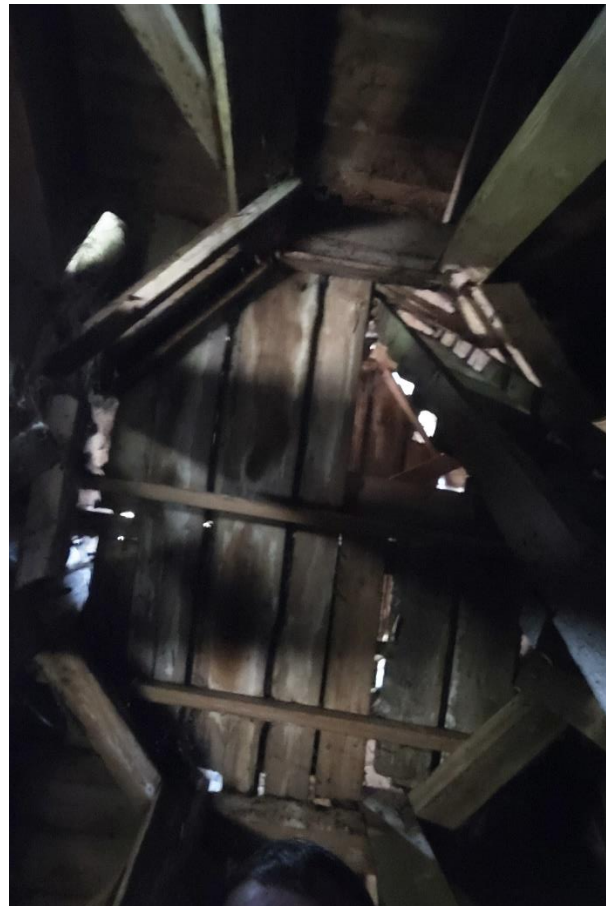
Zdjęcie nr 13, 14 – Konstrukcja drewniana sygnaturki
