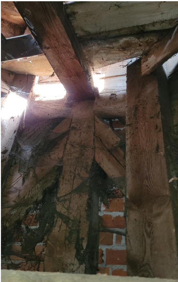
Zdjęcie nr 13, 14 – Konstrukcja drewniana sygnaturki
