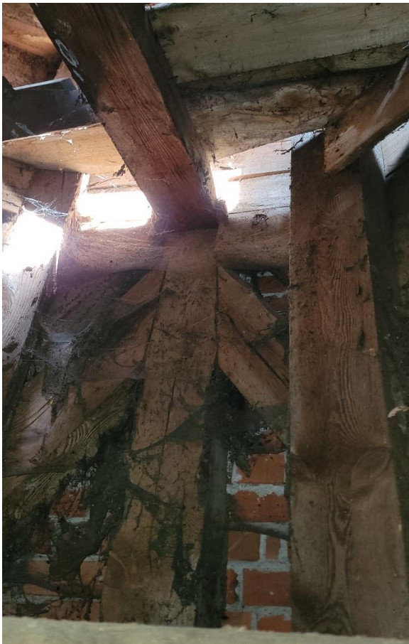
Zdjęcie nr 13, 14 – Konstrukcja drewniana sygnaturki
