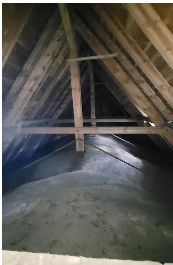
Zdjęcie nr 15, 16 – Konstrukcja dachu
