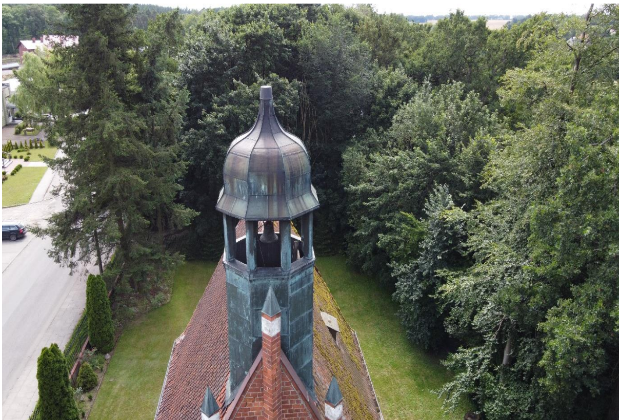
Zdjęcie nr 12 – Sygnaturka – widok ogólny, brak iglicy
