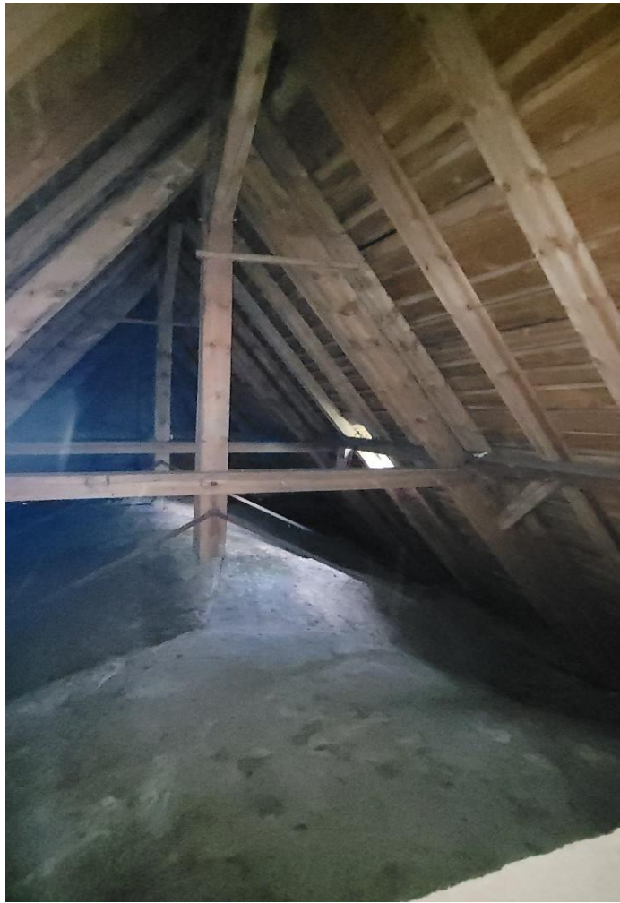
Zdjęcie nr 17 - Konstrukcja dachu wraz ze sklepieniem.
